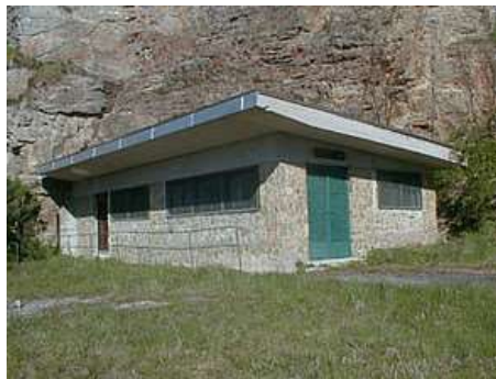
10. ábra. Sopronbánfalvi Geodinamikai Obszervatórium épülete és a mögötte található sziklafal.
