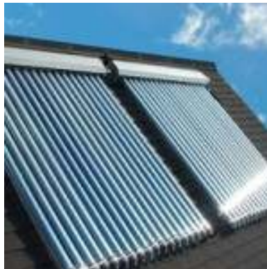
10. kép: Vákuumcsöves napkollektor
