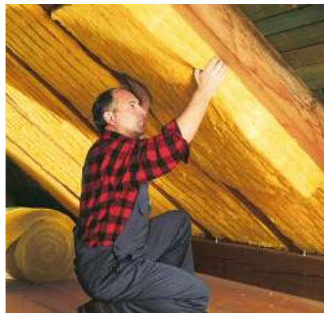
2. kép: Szarufák közti üvegyapot szigetelés
