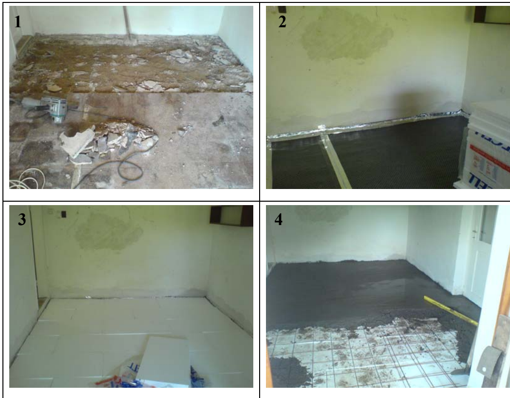
35. ábra: Az étkező radonmentesítésének lépései
