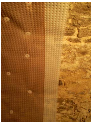
38. ábra: A pince boltozatához rögzített DELTA-PT lemez (A lemez fehér széle jelzi azt a részt, amit a következő lemeznek fednie kell)
