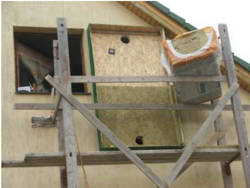
7. kép: A kollektorház szigetelés közben
